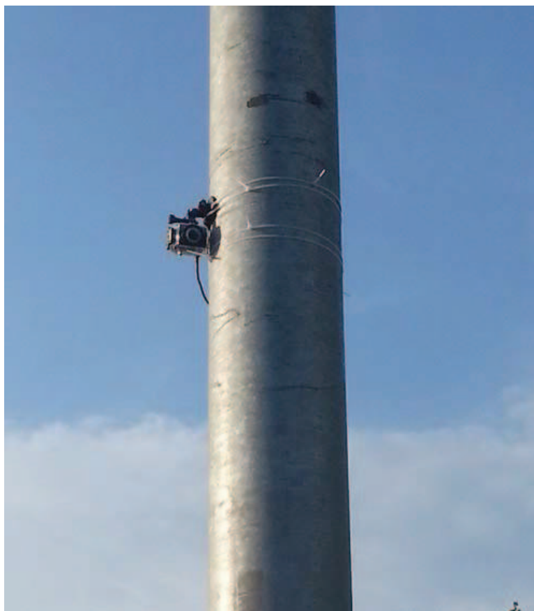
Рисунок 10 – Монтаж видеокамеры на столб линии электроосвещения
