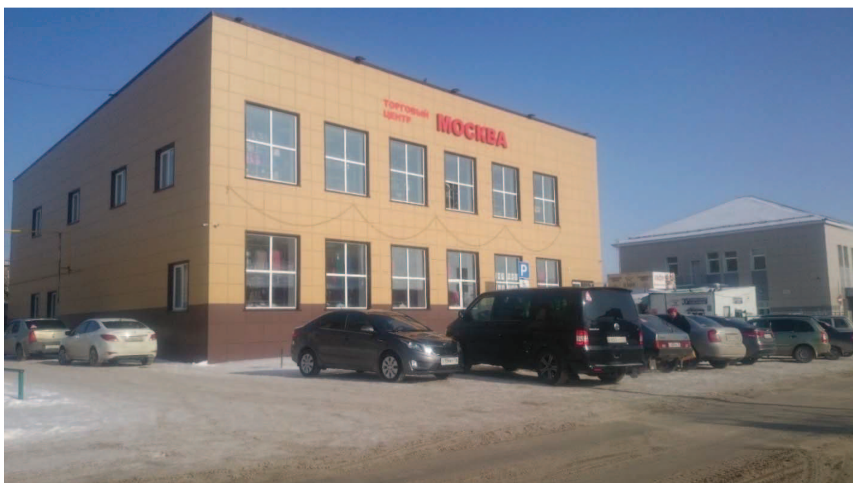
Рисунок 13 – Натурное обследование парковочных мест
