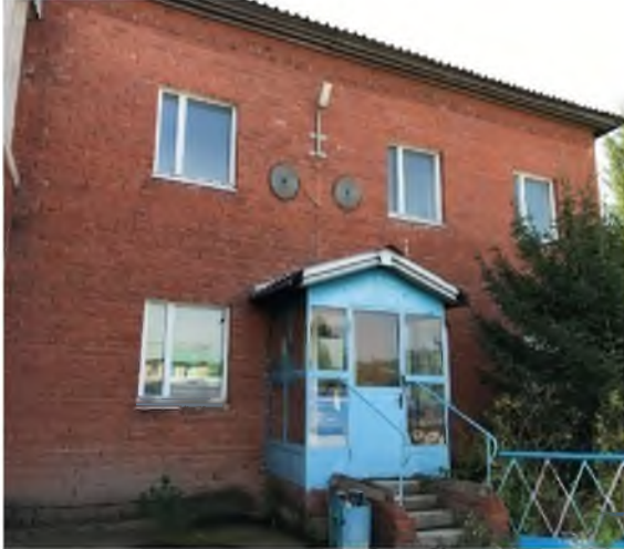
Здание электромонтажной мастерской, дата ввода 31.05.2002, площадь 390 кв.м.
