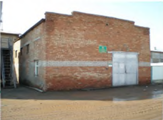
Здание насосной, дата ввода 01.12.1985, площадь 119,0 кв.м.
