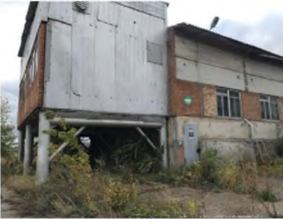
Здание растворобетонного узла РБУ, дата ввода 01.12.1982, площадь 423,0 кв.м.
