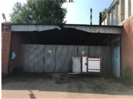
Здание для склада готовой продукции, дата ввода 31.04.2003, площадь 240 кв.м.
